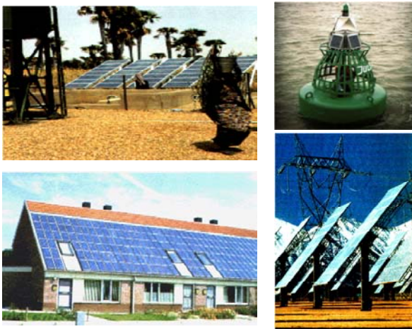
Fig. 20. Les quatre grands secteurs d'application du photovoltaïque : deux exemples en sites isolés (pompage de l'eau et balises maritimes) et en connecté au réseau (toits photovoltaïques, et centrale).
